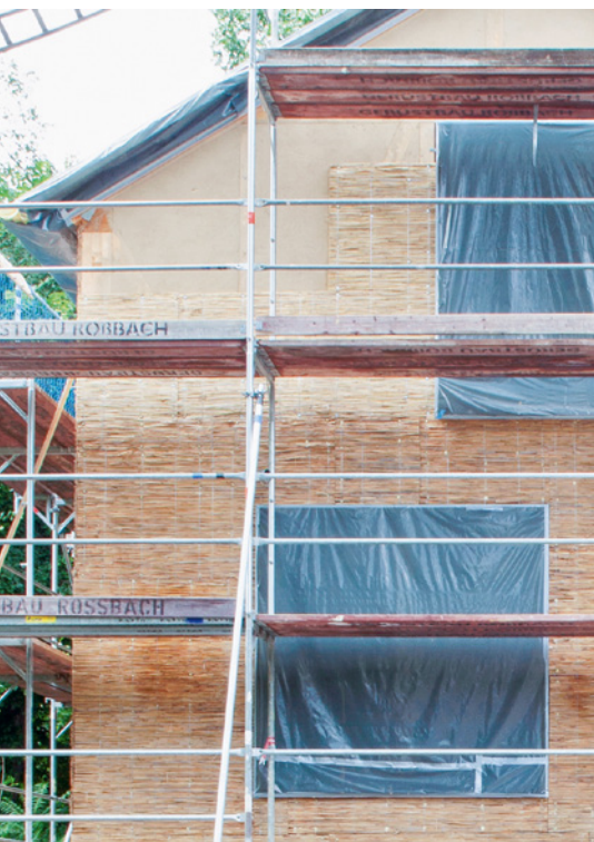
Schilfrohrplatte als Putzträger
