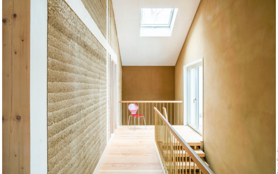
Treppenraum im 1. OG, Mittelwand als Stampflehmwand, Außenwand verputzt mit Wandheizung
