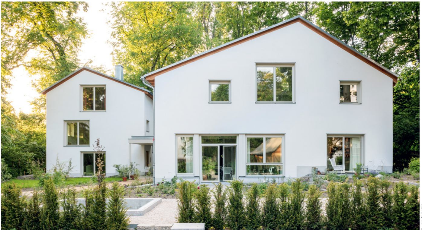
Vorderansicht nach Süden der zweigeschossigen Holz-Lehm-Wohnhäuser
