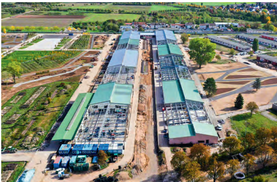
Luftbild der U-Hallen nach Teilrückbau im Sommer 2022
