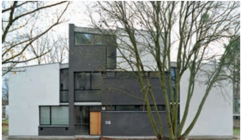
Studentendorf Schlachtensee, Haus 18, Nordfassade nach der Sanierung 2013 Foto: Winfried Brenne Architekten
