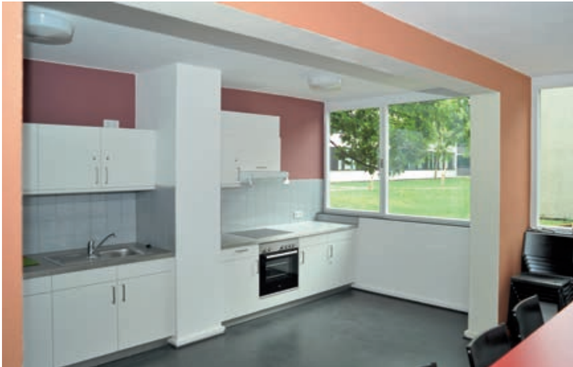
Gemeinschaftsküche im Erdgeschoss, nach der Sanierung 2013
