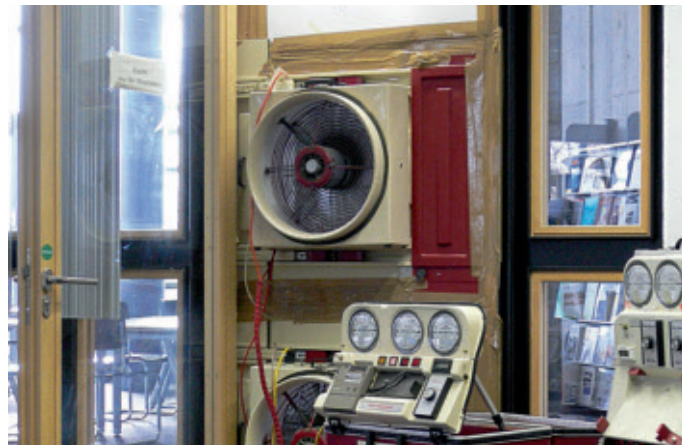
Blower-Door-Test zur Messung der Luftdichtheit, Foto: Roman Jakobiak
