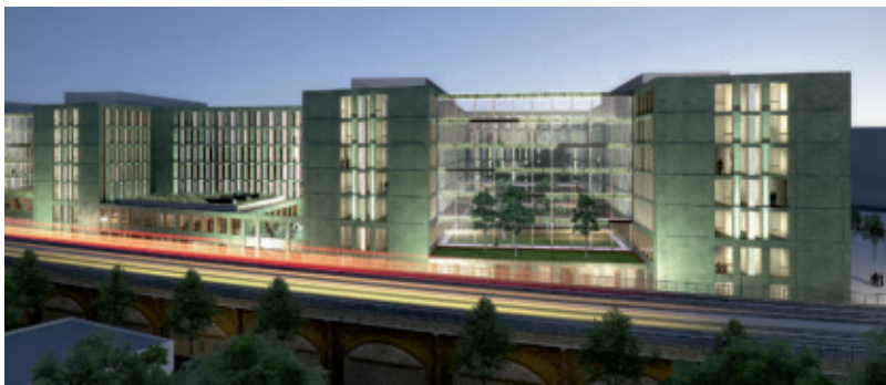
Neubau Bundesministerium für Bildung und Forschung, Dienststelle Berlin am Kapelle-Ufer (Heinle, Wischer und Partner - Freie Architekten)
