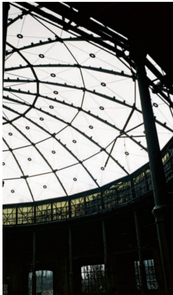
Rundlokschuppen im Rangierbahnhof Berlin-Rummelsburg
