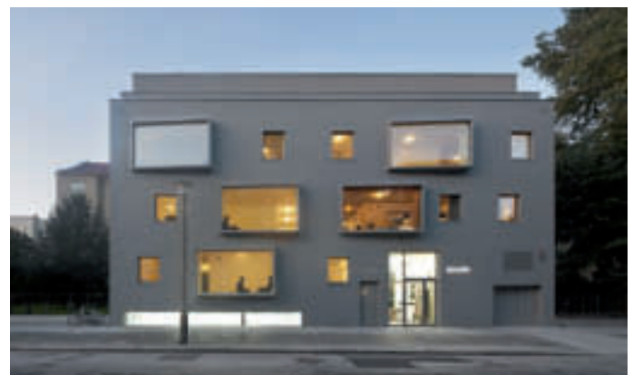
Baugruppenprojekt „Linienstraße 23“, BCO Architekten Foto: Werner Huthmacher
