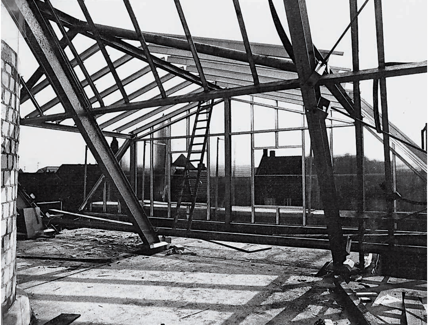
Dach im Bau Roof under construction
