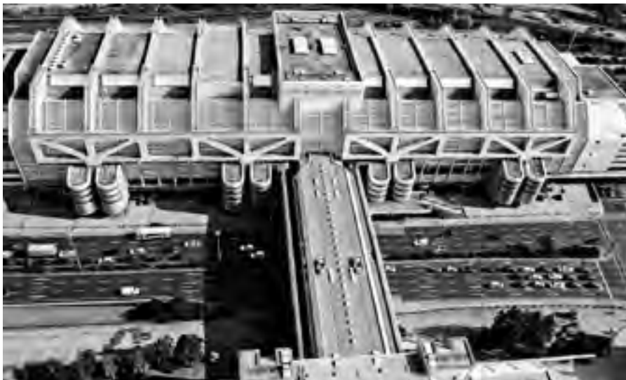
Blick vom Funkturm auf das ICC mit dem Brückenbauwerk über dem Messedamm
