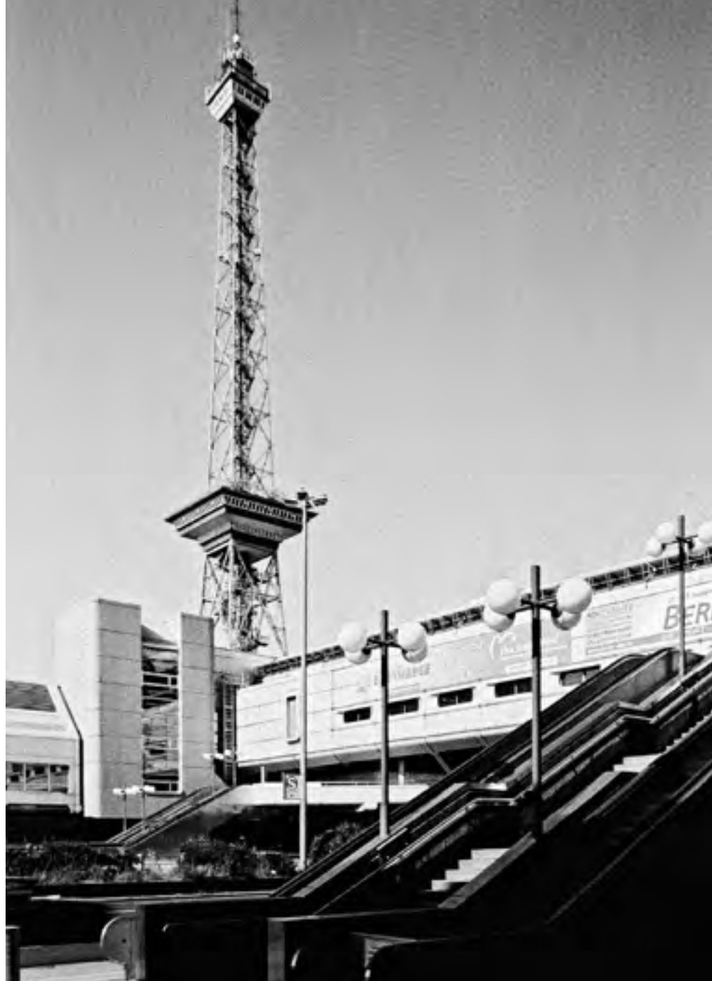
Das Brückenbauwerk über den Messedamm verbindet das ICC mit dem Messegelände auf drei Ebenen
