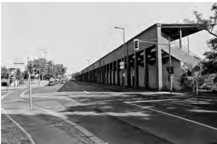
Das funktionslose Baudenkmal AVUS-Tribüne am Ende des Messedamms und am Übergang nach Eichkamp
