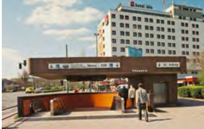
Der Ausstieg in die Passarelle von der Nordseite der Neuen Kantstraße
