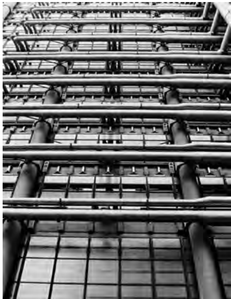
Lloyd's Versicherung von Richard Rogers, 1978–86. City of London, Lime Street
